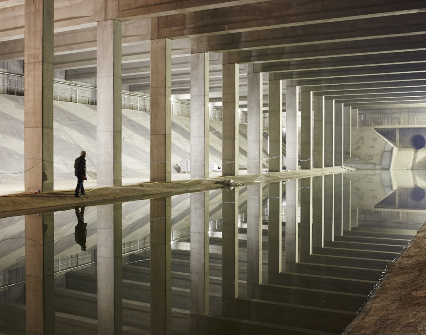
Wasserspeicher Simmering, © Stadt Wien
